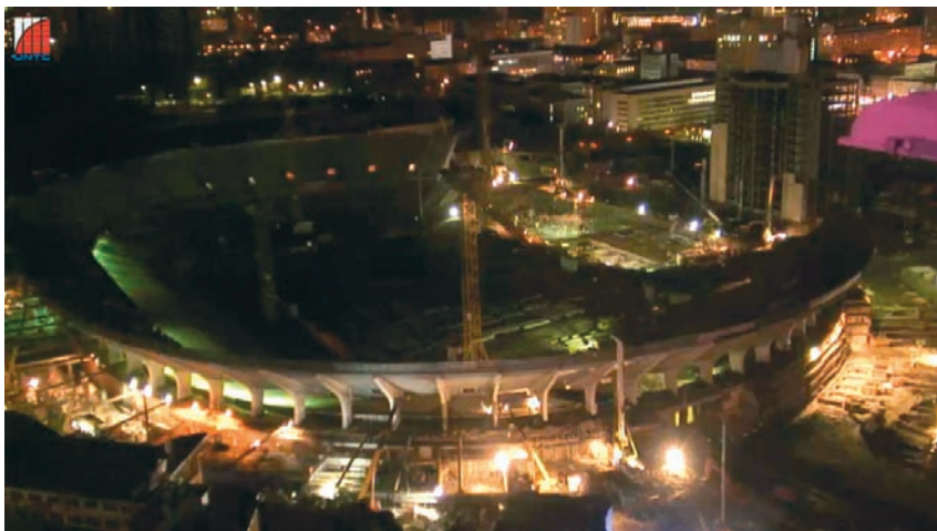
Рис. 13. Онлайн-трансляция процесса строительства НСК «Олимпийский» через pre-WiMAX-сеть UNT Net
