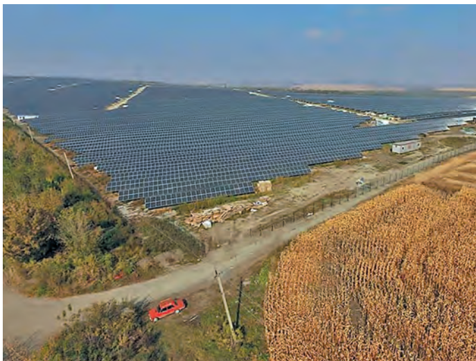
Рис. 9. «Кам'янець-Подільська» СЕС потужністю 63,8 МВт введена в експлуатацію в січні 2019 року
