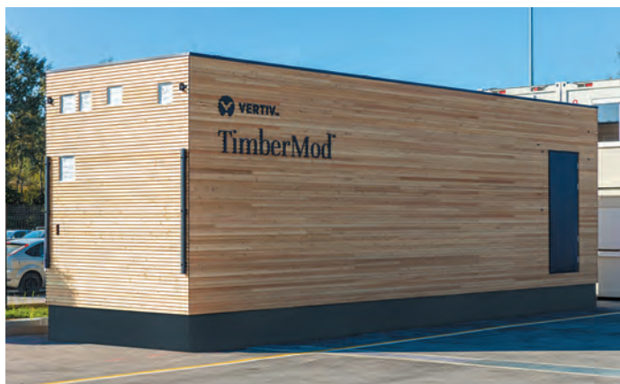
Рис. 11. «Дерев'яний» ЦОД Vertiv TimberMod
