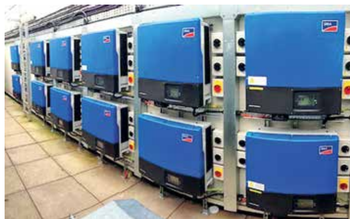
Стринговые инверторы SMA на одном из проектов СЭС
