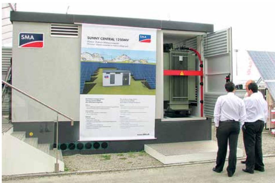
Промышленный инвертор Sunny Central компании SMA
