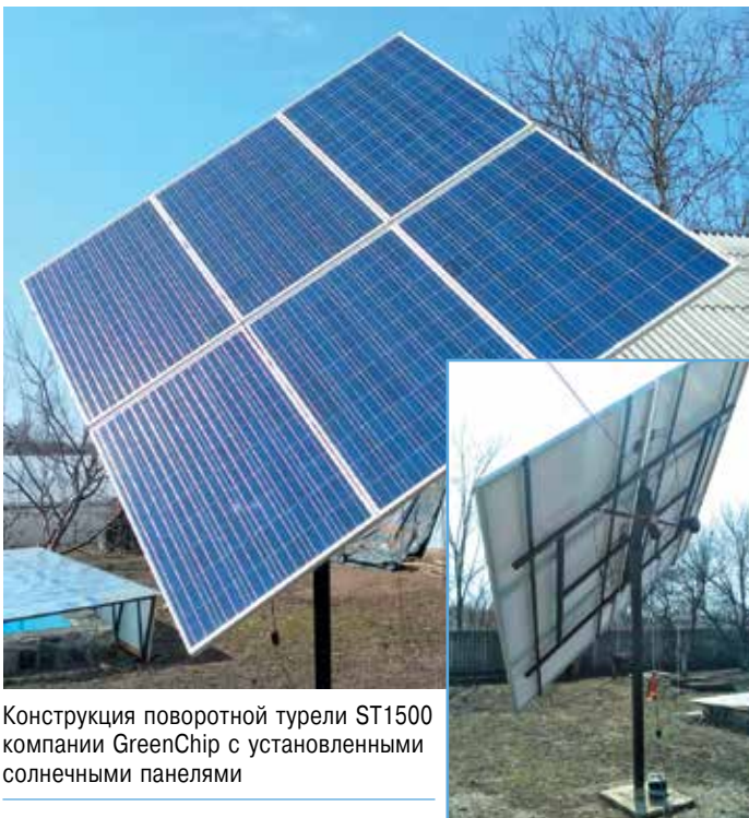
Система динамического слежения фотопанелей за солнцем на СЭС «Ивановка»
