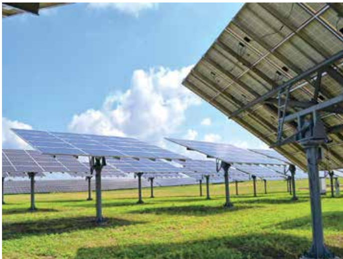
Система слежения за солнцем на «Новенской» СЭС в Запорожской области; проект компании «Токмак Солар Энерджи»
