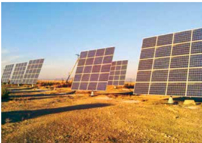
Система динамического слежения фотопанелей за солнцем на СЭС «Ивановка»
