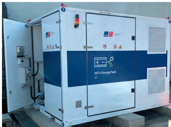
Рис. 7. УЗЕ MTU EnergyPack QS, встановлена в будинку/майстерні для людей з інвалідністю у м. Шпремберг (Німеччина)
