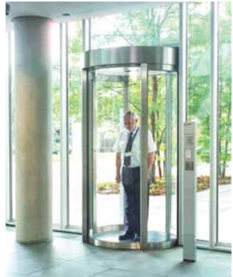
Рис. 4. Шлюзовая кабина («стакан») на входе в помещение дата-центра
