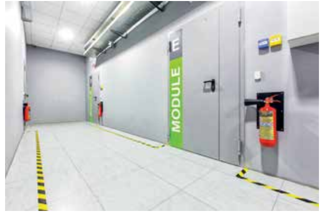
Рис. 8. Укрепленные двери, установленные на входах в машинные залы украинского ЦОД Gigacentер
