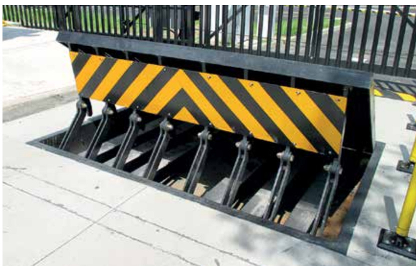
Рис. 2. Противотаранная система, установленная на въезде в один из американских ЦОД. Такое решение может остановить если не танк, то, по крайней мере, крупный грузовик
