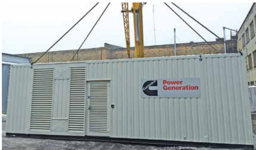
Рис. 1. Генератор Cummins в нестандартном контейнере (проект «Далгакиран компрессор Украина»)
