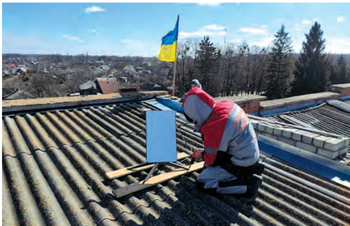
Рис. 2 Технік провайдера HomeNet встановлює станцію Starlink у Любечі (з твіта Михайла Федорова). Тут не «тарілка», а термінал нового зразка — прямокутний.
