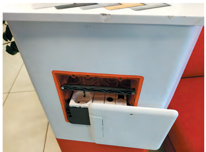
Рис. 4. Встраиваемые лючки Legrand: новинка (на заднем плане) — крышка не фиксируется и поэтому закрыта — и вариант для монтажа в стену
