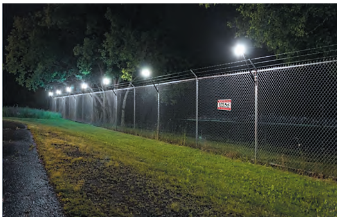
Рис. 2. Приклад розумного освітлення з підсвічуванням лінії огорожі і вбудованими давачами проникнення (джерело: Senstar)
