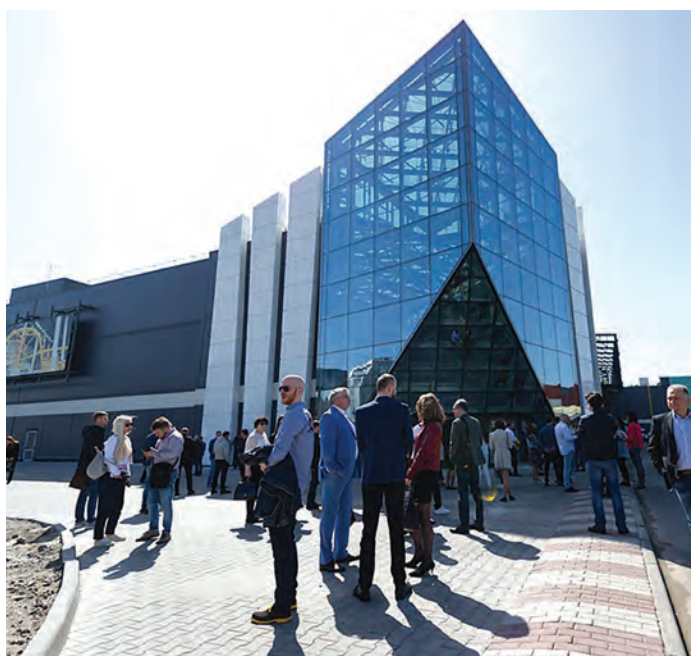
Рис. 4. ТРЦ Blockbuster Mall, при построении которого было использовано оборудование DKC
