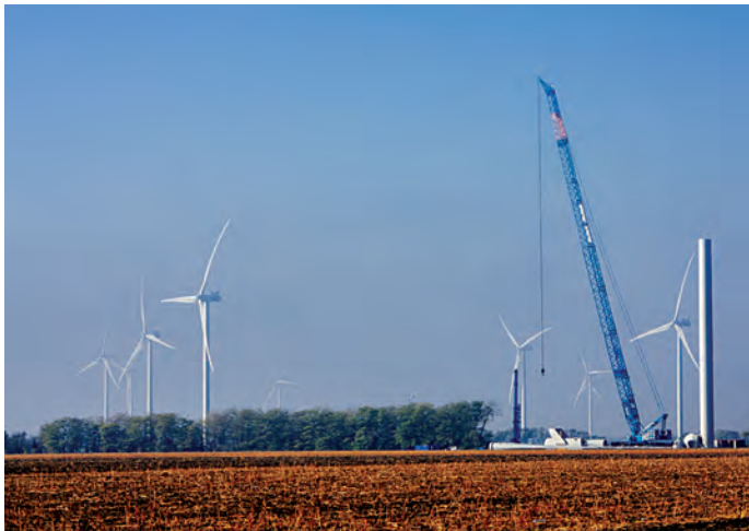
Этапы строительства ветроустановок Ботиевской ВЭС
