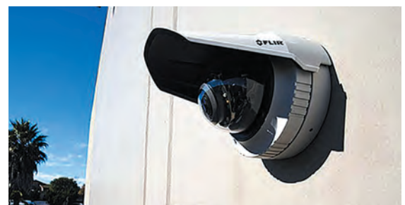
Рис. 6. Камера видеонаблюдения FLIR Quasar Premium Mini-Dome, установленная на объекте
