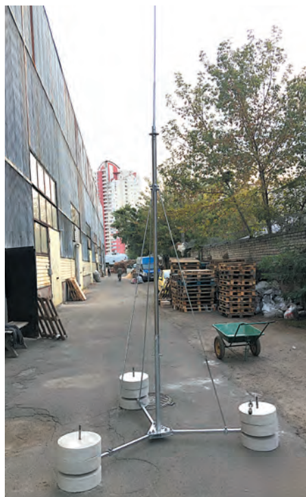
Рис. 3. Використання бетонних опор для блискавкоприймальних щогл KovoFlex
