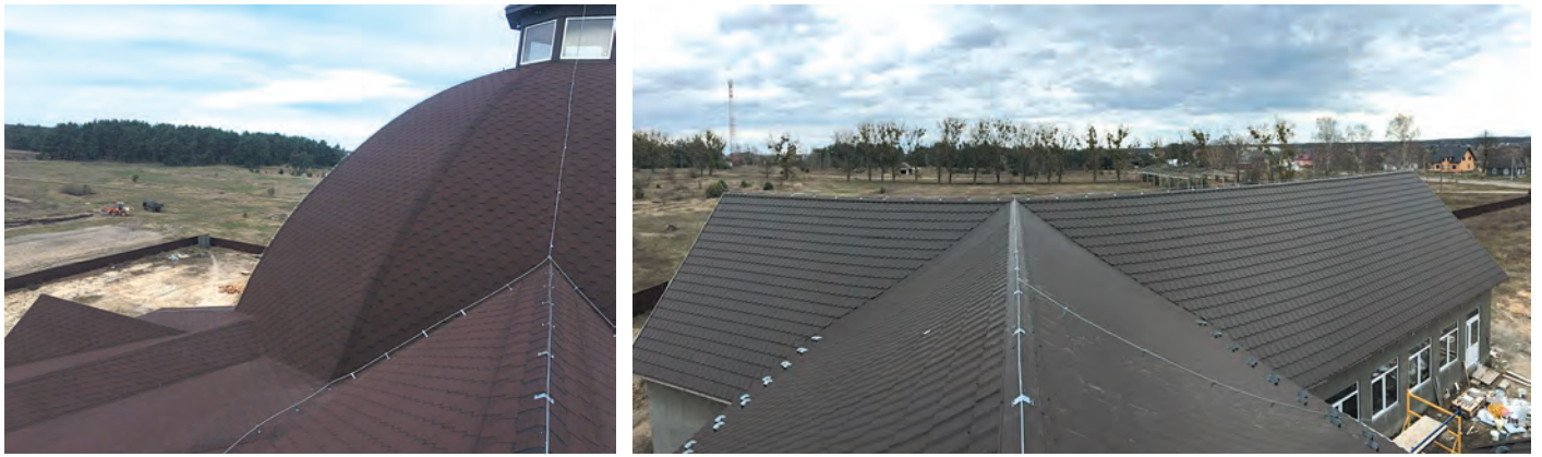
Рис. 4. Система блискавкозахисту KovoFlex для молитовної споруди
