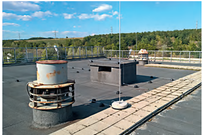
Рис. 9. Приклад комбінованого використання блискавкоприймальної сітки та штирьових блискавкоприймачів E.NEXT
