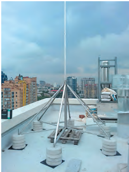
Рис. 5. Блискавкозахист багатоквартирного житлового комплексу (м. Київ) з використанням щогл «Лео Лайтмен»
