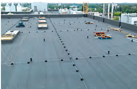
Рис. 10. Система блискавкозахисту на плоскому даху (а) використовує спеціальні тримачі дроту (б, в) — проект на обладнанні E.NEXT
