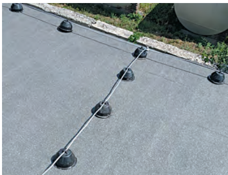
Рис. 12. Монтаж блискавкоприймальної сітки на даху ТЕС — проект на обладнанні KovoFlex
