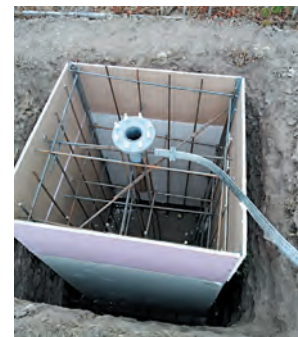
Рис. 13. Станція ПЗМ, розташована на території ТЕС, захищена 14-метровими блискавкоприймачами (а) з анкерним фундаментом під заливку (б)
