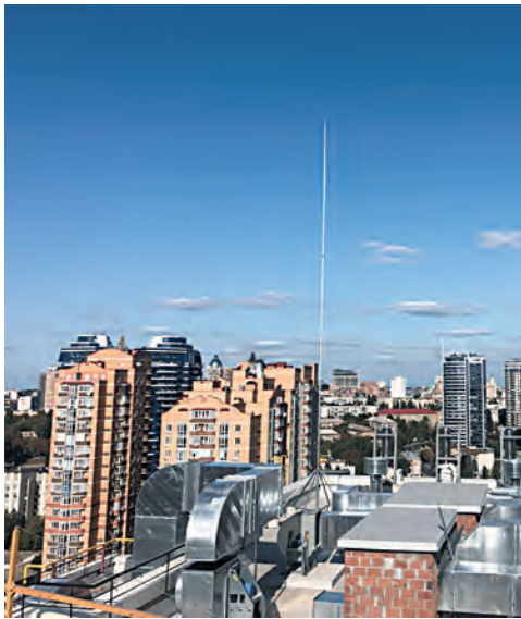
Рис. 5. Блискавкозахист багатоквартирного житлового комплексу (м. Київ) з використанням щогл «Лео Лайтмен»
