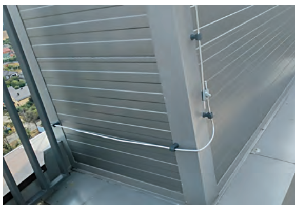
Рис. 14. Захист від блискавки житлового будинку на обладнанні KovoFlex
