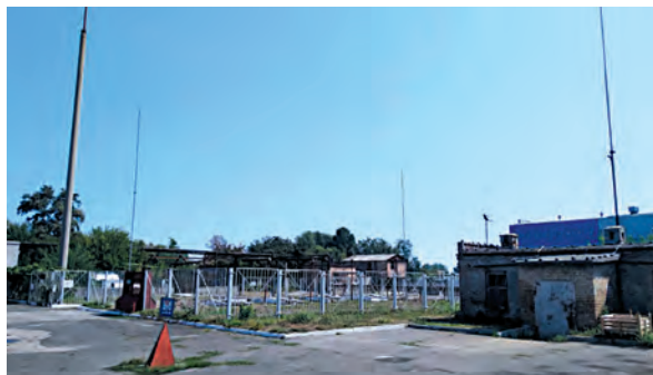
Рис. 13. Станція ПЗМ, розташована на території ТЕС, захищена 14-метровими блискавкоприймачами (а) з анкерним фундаментом під заливку (б)
