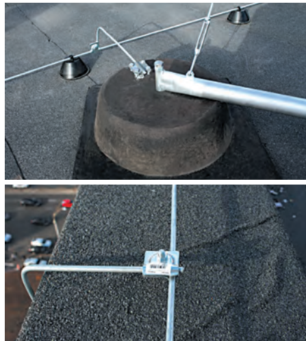
Рис. 2. Блискавоприймальна щогла системи Jupiter висотою 10 м на даху бізнес-центру «Петрівка»
