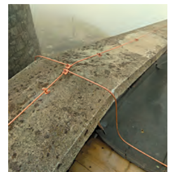
Рис. 3. Блискавкозахист будівлі обсерваторії на Чорній горі (Івано-Франківська обл.)
