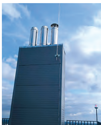
Рис. 14. Захист від блискавки житлового будинку на обладнанні KovoFlex
