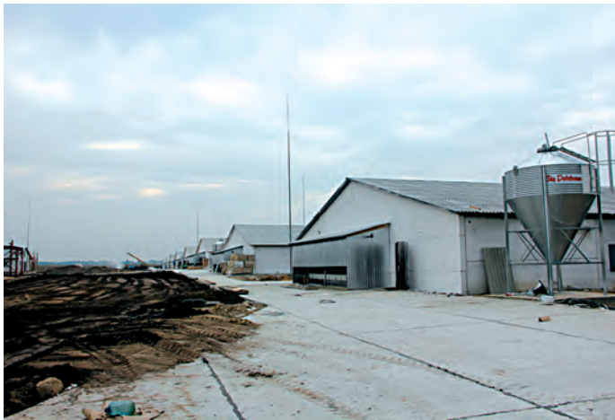
Рис. 8. Використання блискавкоприймальних щогл E.NEXT на одному з об'єктів агропромислового комплексу
