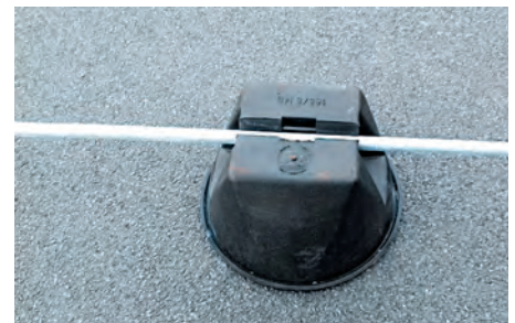
Рис. 10. Система блискавкозахисту на плоскому даху (а) використовує спеціальні тримачі дроту (б, в) — проект на обладнанні E.NEXT
