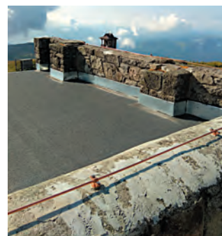
Рис. 3. Блискавкозахист будівлі обсерваторії на Чорній горі (Івано-Франківська обл.)
