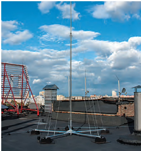
Рис. 2. Блискавоприймальна щогла системи Jupiter висотою 10 м на даху бізнес-центру «Петрівка»
