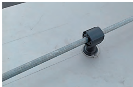
Рис. 10. Система блискавкозахисту на плоскому даху (а) використовує спеціальні тримачі дроту (б, в) — проект на обладнанні E.NEXT
