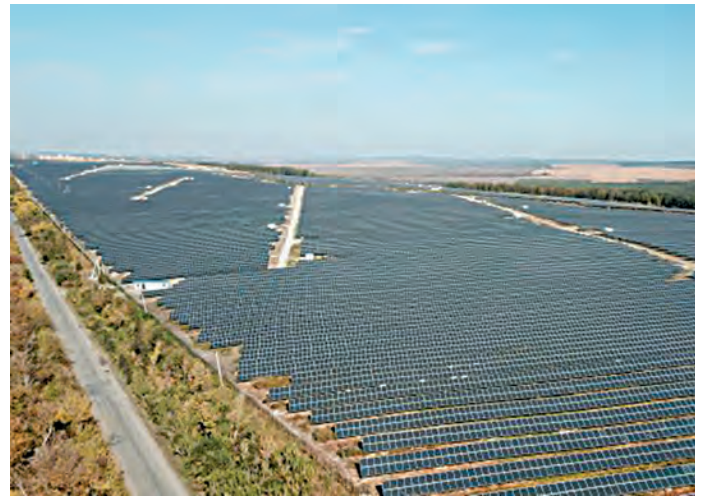
Рис. 6. Кам'янець-Подільська СЕС, Хмельницька обл., потужністю 63,8 МВт
