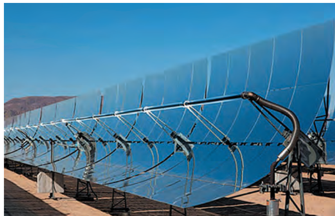
Параболические зеркала в проекте «Ашалим А» концентрируют солнечное излучение, нагревая циркулирующее по трубе масло
