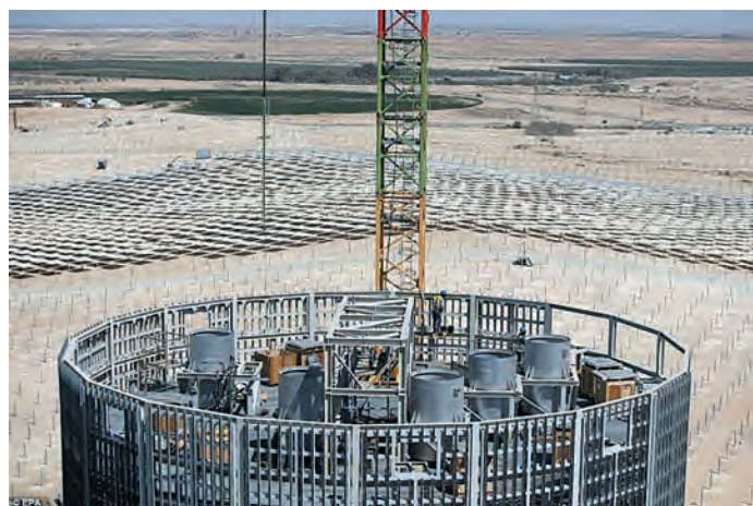
Этапы строительства СЭС «Ашалим В» концентрационного типа с центральной башней
