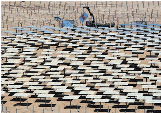
Установка зеркал-гелиостатов для СЭС «Ашалим В»
