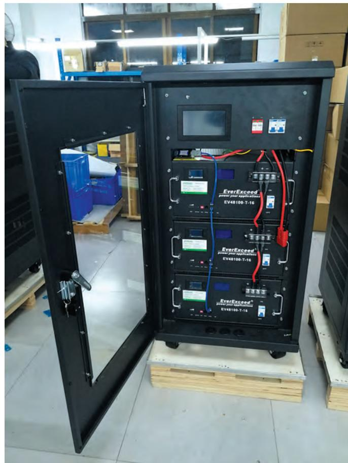
Рис. 8. АКБ EverExceed (48 В, 300 А·ч) в батарейном шкафу
