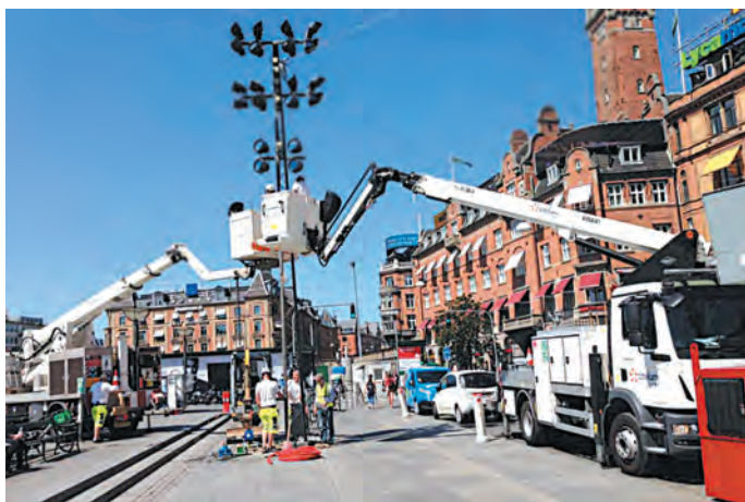
Рис. 7. Фрагмент уличной лаборатории DOLL, развернутой в пригороде Копенгагена для моделирования работы систем «умного» городского освещения
