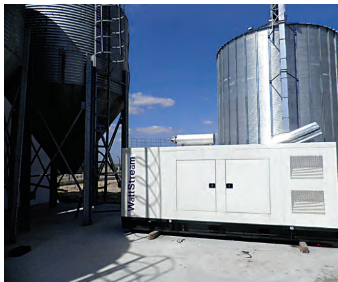
Рис. 3. Генератор Weichai WS412-WS на свиноферме предприятия «ДАН-Фарм Украина»
