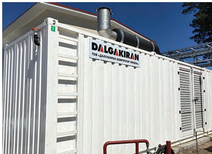
Рис. 9. Высоковольтный генератор Dalgakiran в контейнере
