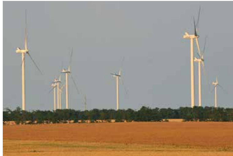
Ботиевская ВЭС мощностью 200 МВт; ООО «Винд Пауэр» (ДТЭК), Запорожская область; 65 ветротурбин Vestas V112 единичной мощностью 3,075 МВт (фото автора)
