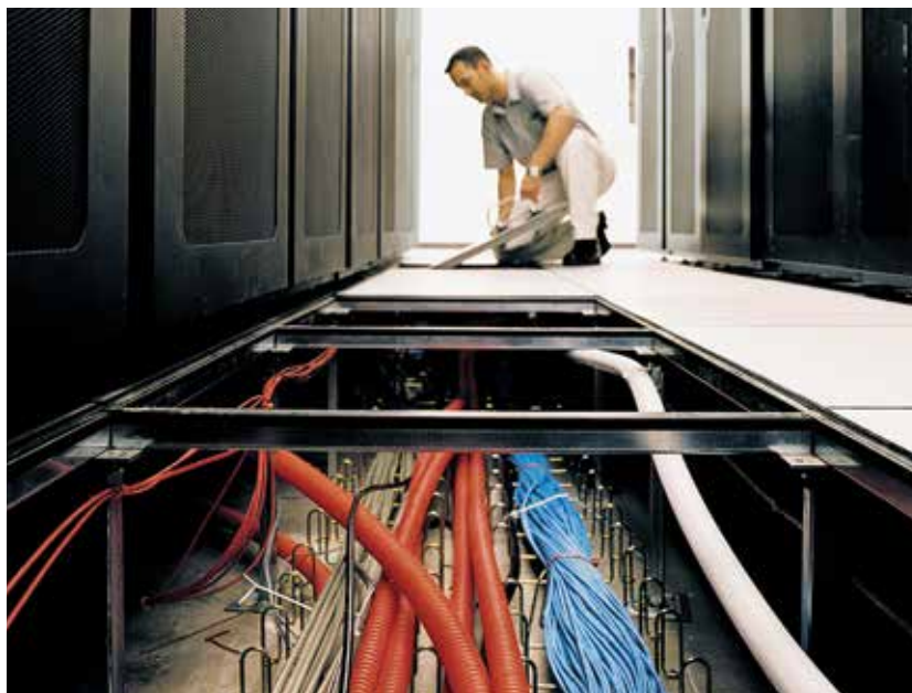
Рис. 1. Монтаж фальшпола Warpex в центре обработки данных
